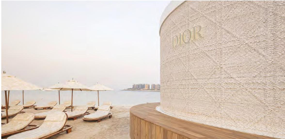
L'espace éco-conçu déployé par Dior sur la plage de Nammos, à Dubaï, a été obtenu en impression 3D à partir de la superposition de couches d'argile, de sable et de fibres naturelles.
